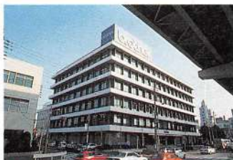
名古屋市瑞穂区にあるブラザー工業本社ビル
